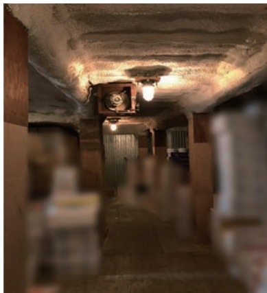
冷凍庫交換前
